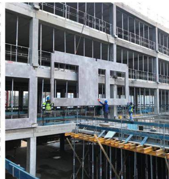
Fertigteile werden gesetzt
