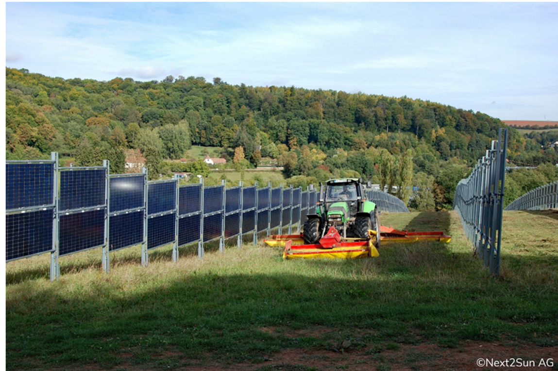
©Next2Sun Vertikale APV-Anlage mit bifazialen Modulen.
