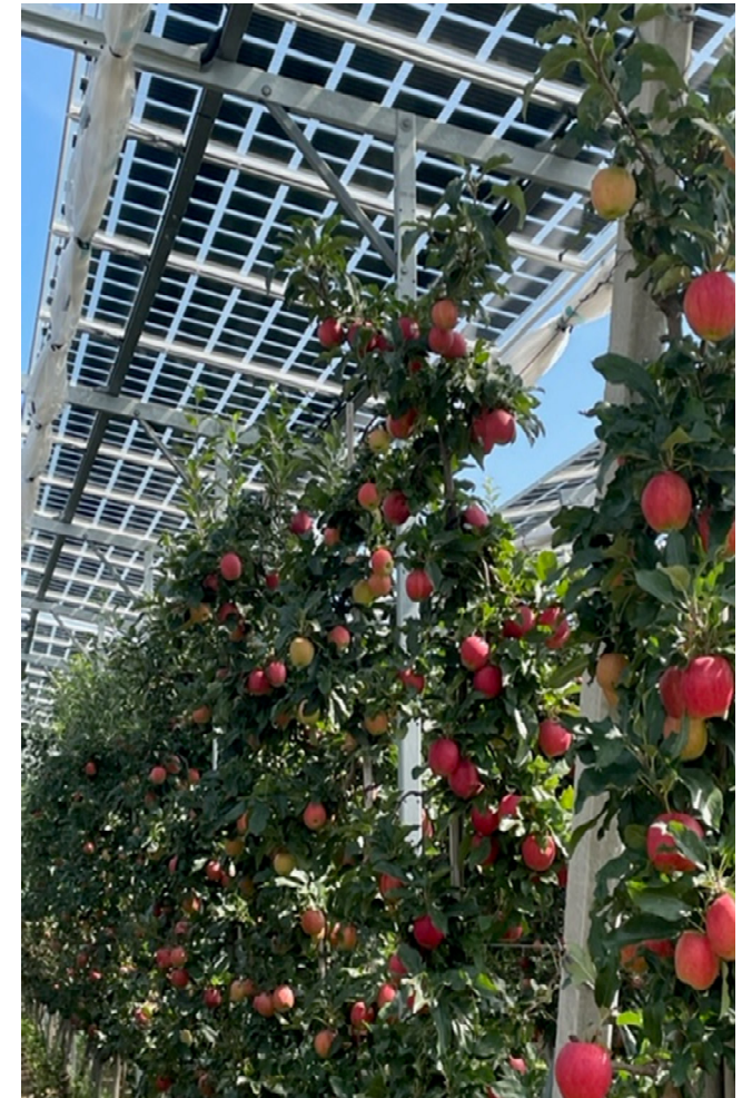
Agri-PV Anlage im Obstbau. ©AgriPV-Solutions
